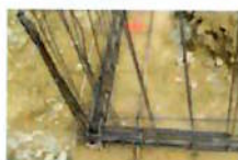
Nœud de chaînage - Continuité mécanique
